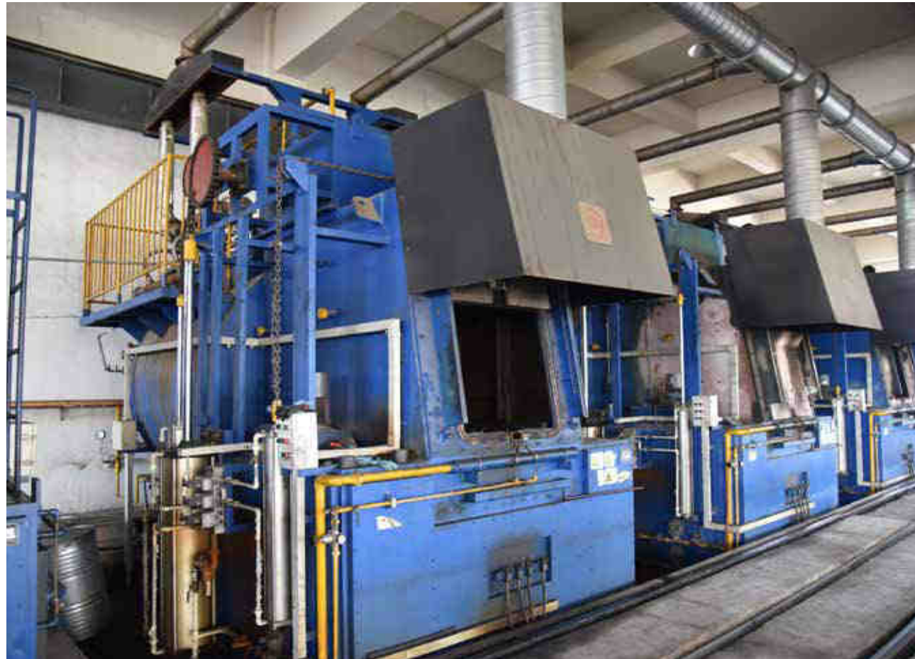
Trattamento Termico - Heat treatment
