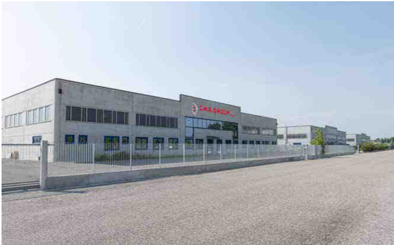
Sede - Branch Porto Mantovano (Mantova) Italy
